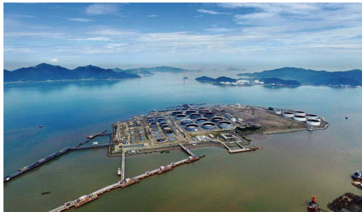
舟山石油储备基地
