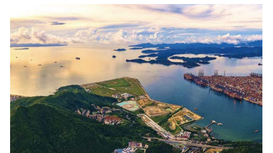
盐田港区东作业区 集装箱码头工程开工活动
