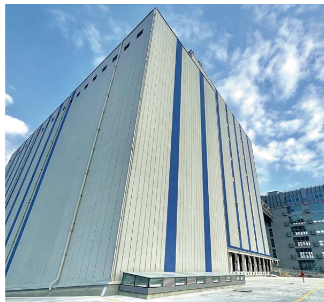
盐田港冷链服务仓项目工程顺利通过竣工验收
